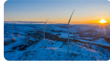
Vindpark Stigafjellet i Bjerkheim kommun i Norge.
