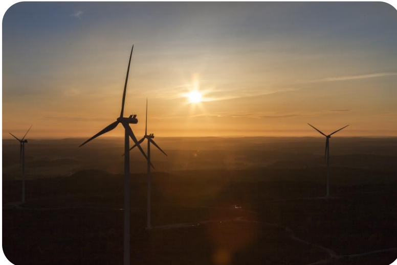
Tolvmanstegen i Strömstads kommun.
