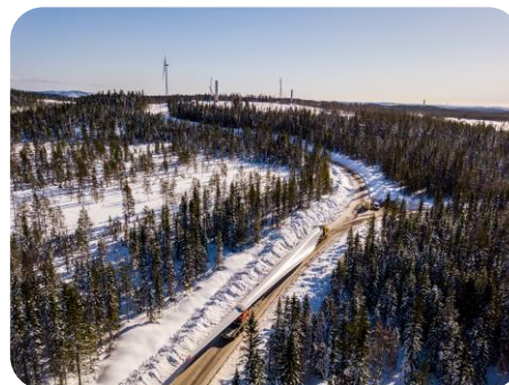
Vindpark Jenåsen i Sundsvalls kommun.
