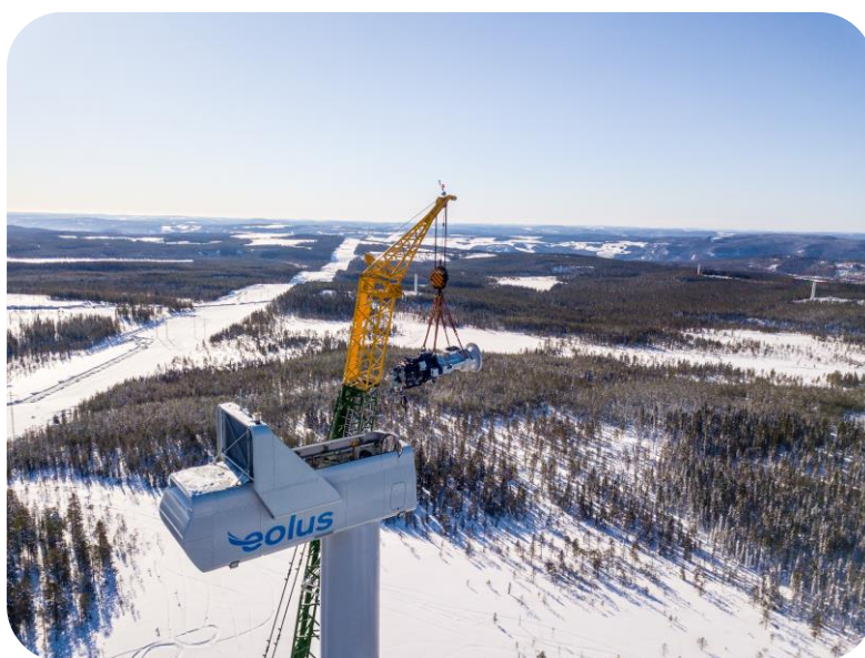
Byggnation av vindpark Jenåsen i Sundsvalls kommun.
