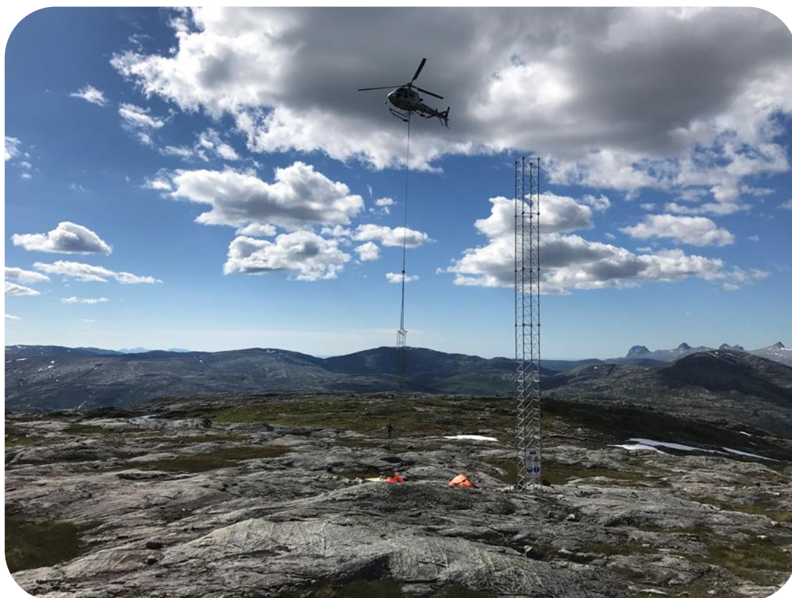
Montering av vindmätmaster på Öyfjellet.
