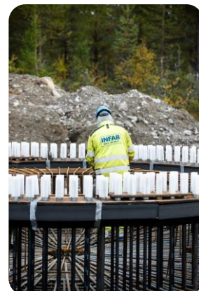
Byggnation av vindpark Jenåsen.
